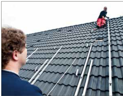
Schrägdachmontage
